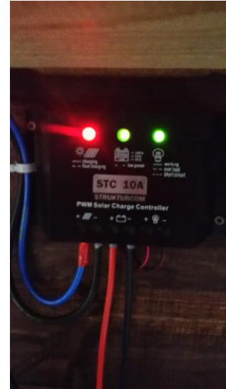
Слика 27. Контролни уређај довода напона струје са соларног панела Figure 27. The control unit of the solar panel power supply system
